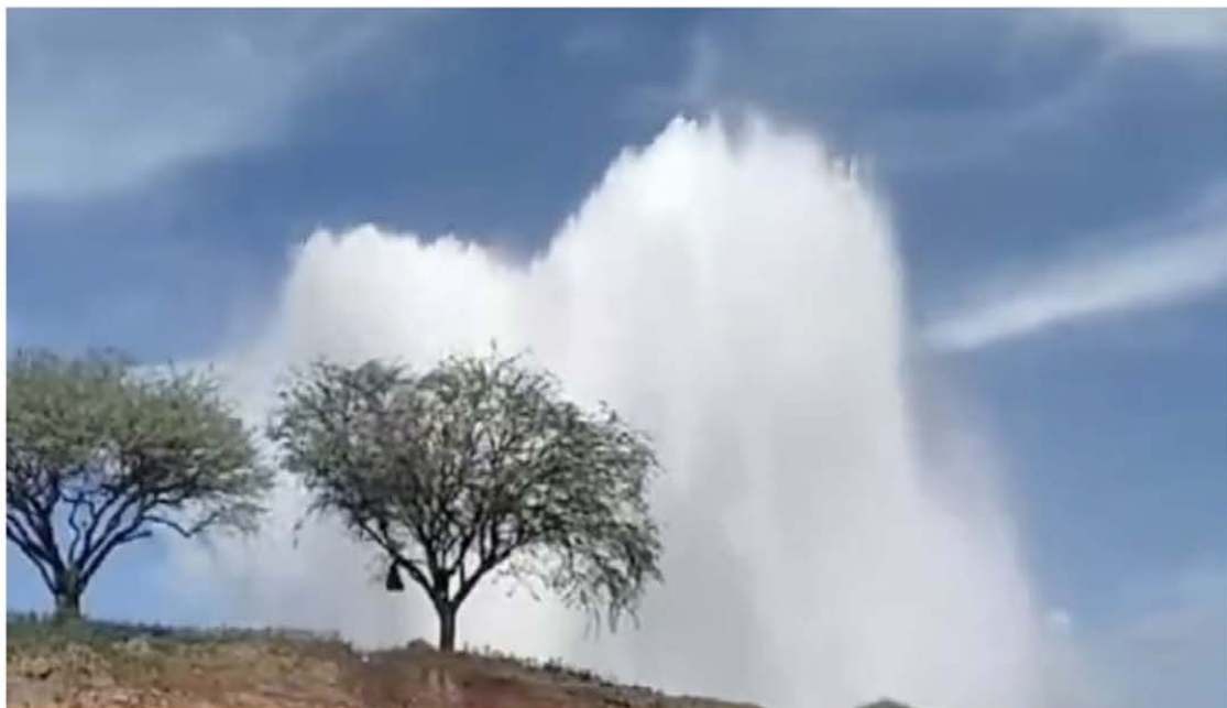
Suspensión de servicio por fuga de agua en Acueducto II en Querétaro.
