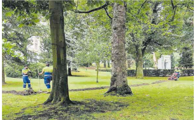
Operarios, ayer, preparando la red de suministro de la fuente del monumento a Clarín. | L. B.
